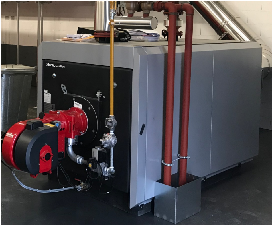
Chaudière gaz d'appoint secours
